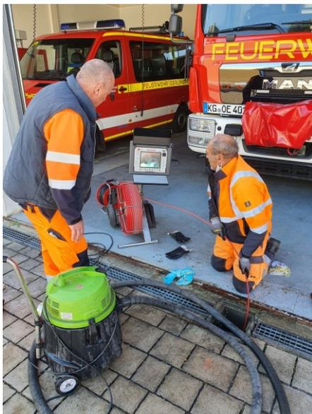
Zwischenzeitlich hat unser Bauhof die Entwässerungsleitung am Feuerwehrhaus in Oerlenbach ausgetauscht. Dort waren leider Teile der Rohrleitung beschädigt. Mittels einer Kamerabefahrung konnte das Problem lokalisiert werden. Ein Dank gilt den Mitarbeitern des Bauhofs, die den Schaden selbstständig beheben konnten.
